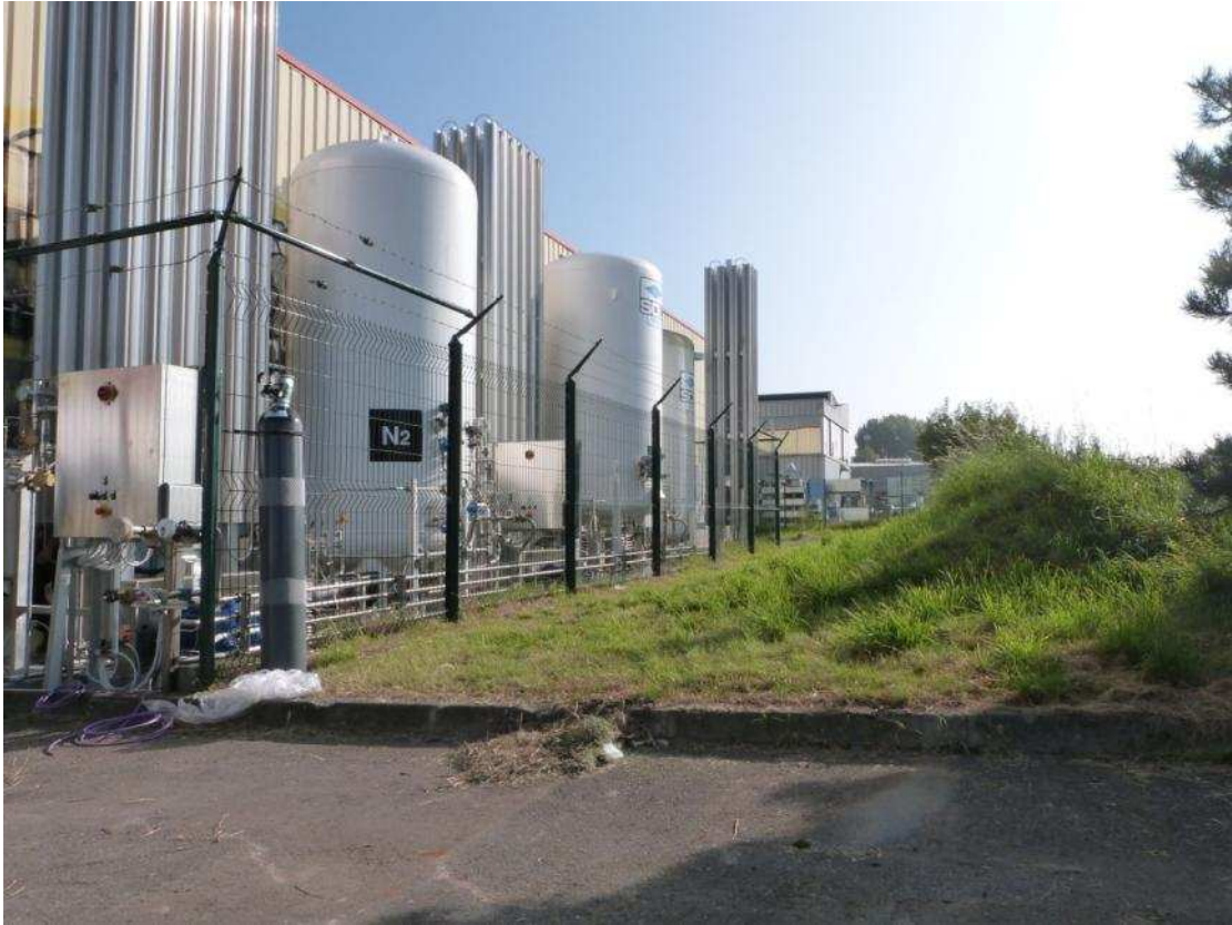
Photo 5 : stockage Gaz au Sud du Bâtiment le long de la RN184
