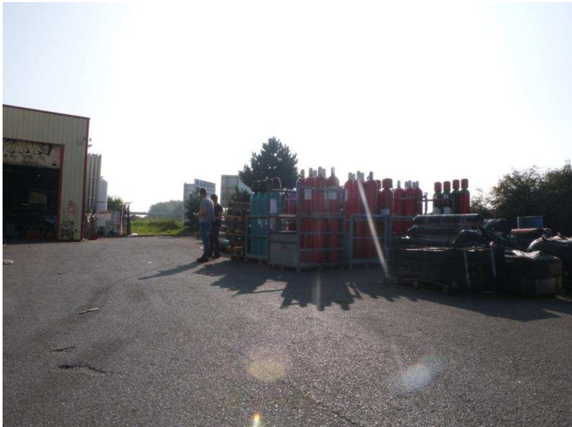
Photo 4 : Stockage extérieur et entrée Ouest de l'atelier
